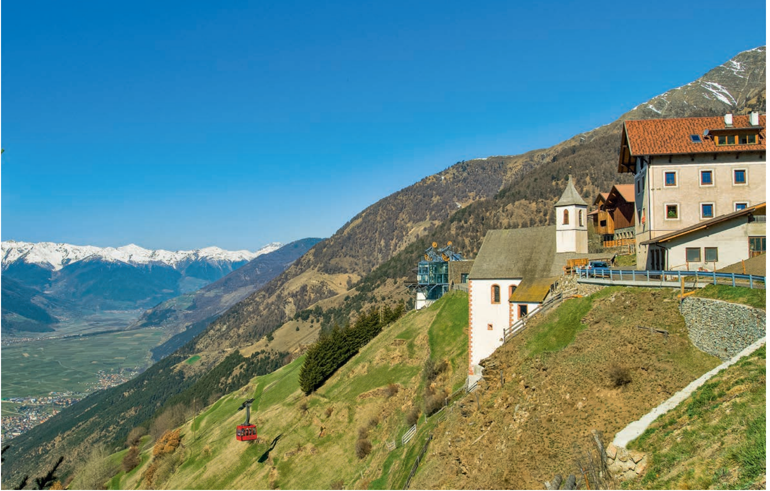
Das in den Hang hinein gebaute Wallfahrtskirchlein von Sankt Martin im Kofel wacht über den seit Jahrtausenden von Menschen bewohnten und mühsam bewirtschafteten Vinschgauer Sonnenberg.
