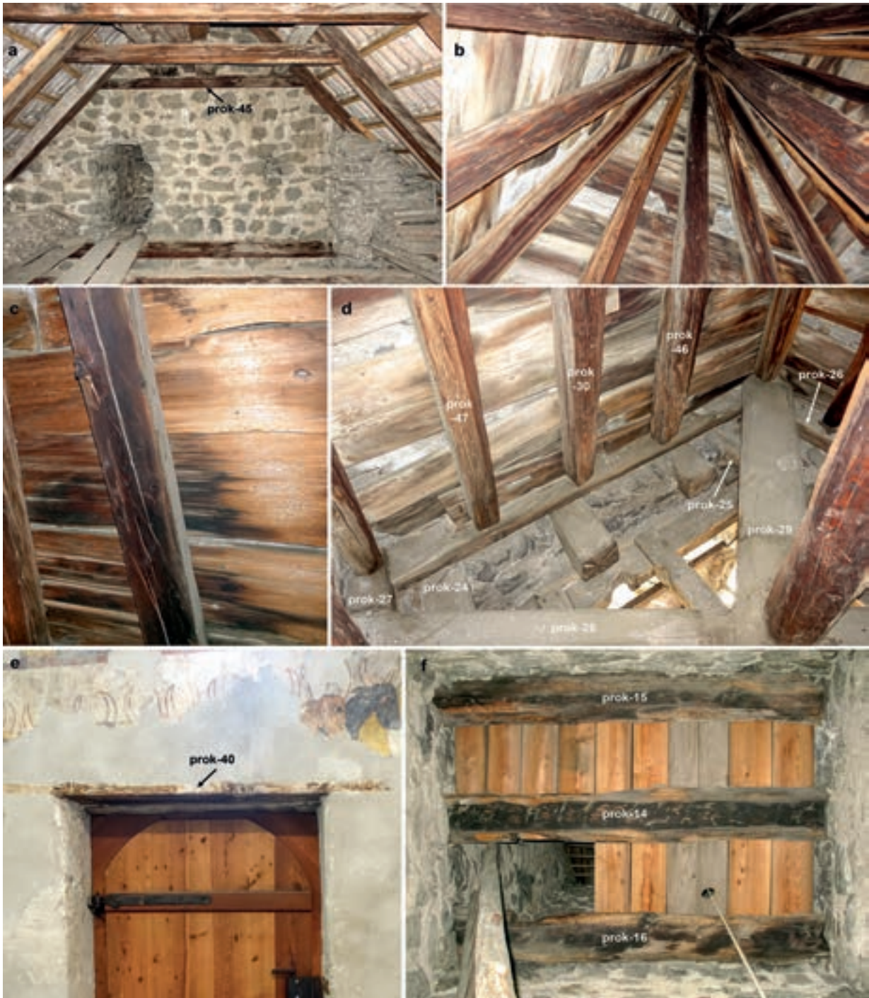
Abb. 5: Holzkonstruktionen und beprobte Hölzer:
