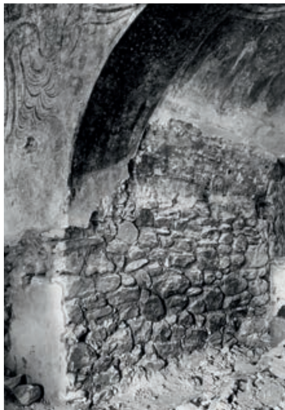
Abb. 3: Nördliche Chorwand während der Maßnahmen von Giuseppe Gerola 1923/24 (Foto: Perdomi, Amt für Bau- und Kunstdenkmäler, Bozen)
