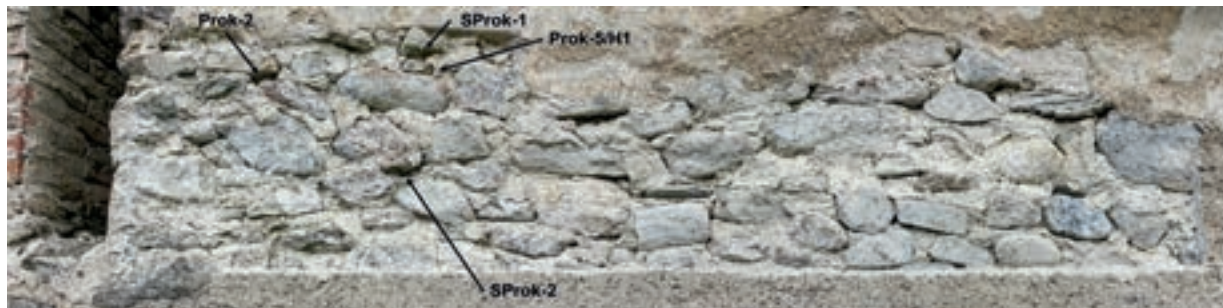
Abb. 1: Das zur Bauuntersuchung angelegte Putzfenster am östlichen Ende der Nordmauer des Kirchenschiffs. Das Mauerwerk zeigt keinerlei Hinweise auf eine Abrisszone mit späterer Neuaufmauerung im Bereich der Ostwand des Schiffs, vielmehr ist eine einheitliche Bauerrichtung nachweisbar. Dokumentiert sind die Entnahmepositionen der 14 C-datierten organischen Reste (Prok-2, Prok-5/H1) und Mörtelproben (SProk-1, SProk-2) (Foto: Kurt Nicolussi, Zustand 2018).
