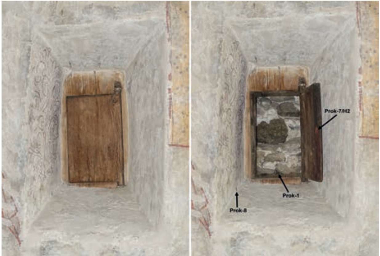
Abb.4: Das heute vermauerte Fenster in der Südwand des Kirchenschiffs. Die Außenseite des Fensterflügels zeigt deutliche Spuren der Verwitterung. Dokumentiert sind die Entnahmepositionen der 14 C-Proben (Fotos: Kurt Nicolussi, Zustand 2018).
