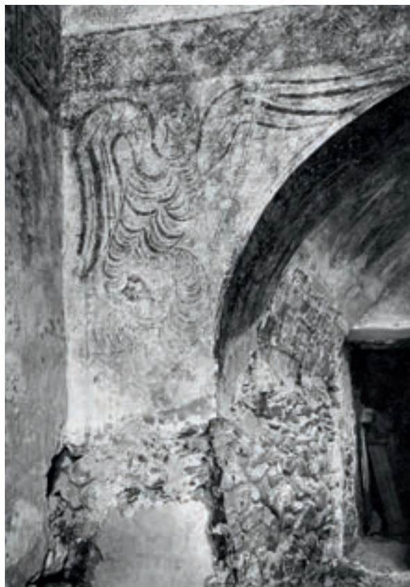
Abb. 2: Nördliche Triumphbogenwand während der Maßnahmen von Giuseppe Gerola 1923/24 (Foto: Perdomi, Amt für Bau- und Kunstdenkmäler, Bozen)
