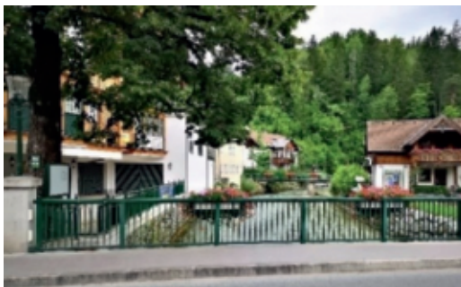
Foto oben: Bad Aussee. Erzherzog Johann Brücke (1936 erbaut) über die Grundlsee Traun.
