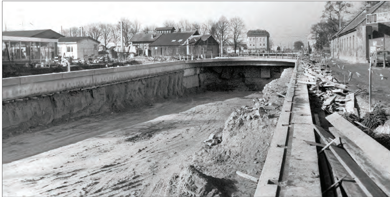
Drei Jahre wurde an der Unterführung gebaut, große Mengen an Erde wurden bewegt.
