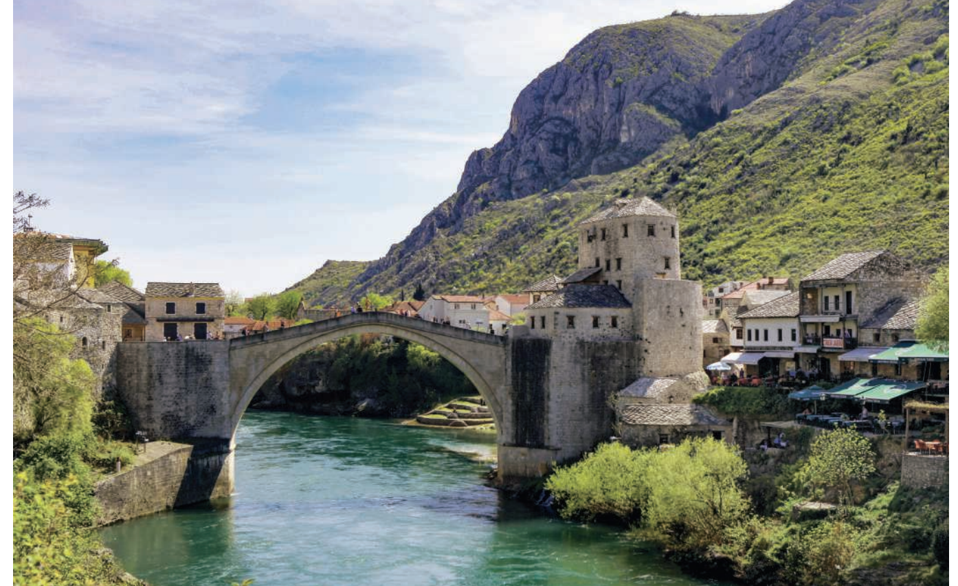
Die unter UNESCO-Denkmalstatus stehende alte Steinbrücke von Mostar
