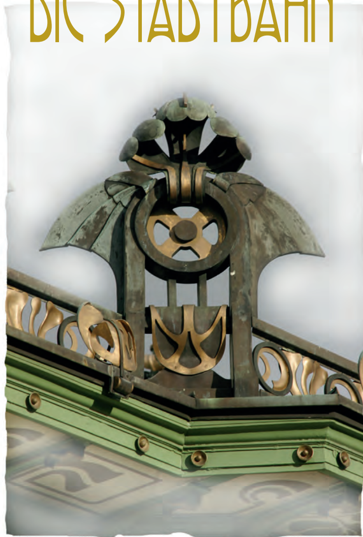
Detail der Stadtbahnstation Karlsplatz
