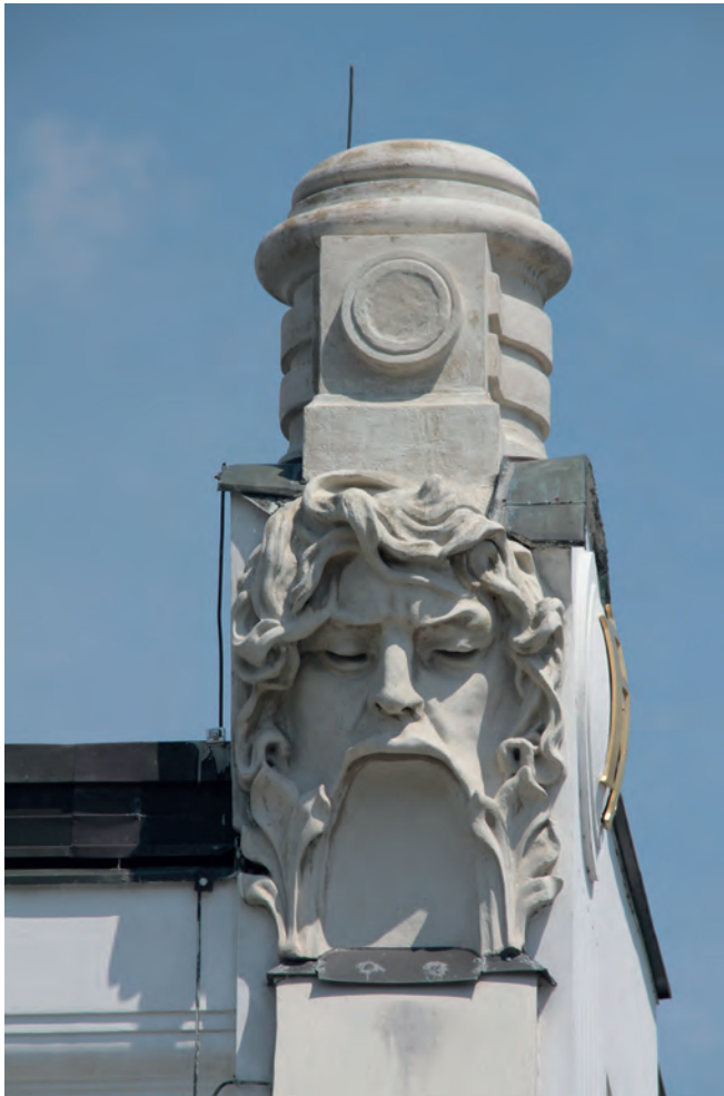
Dachreiter/Rauchfang am Hofpavillon Hietzing
