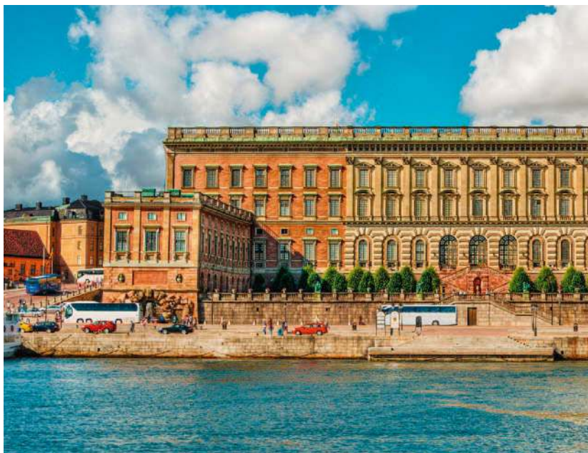
Die Nordfassade des Stockholmer Schlosses vom Norrström aus gesehen
