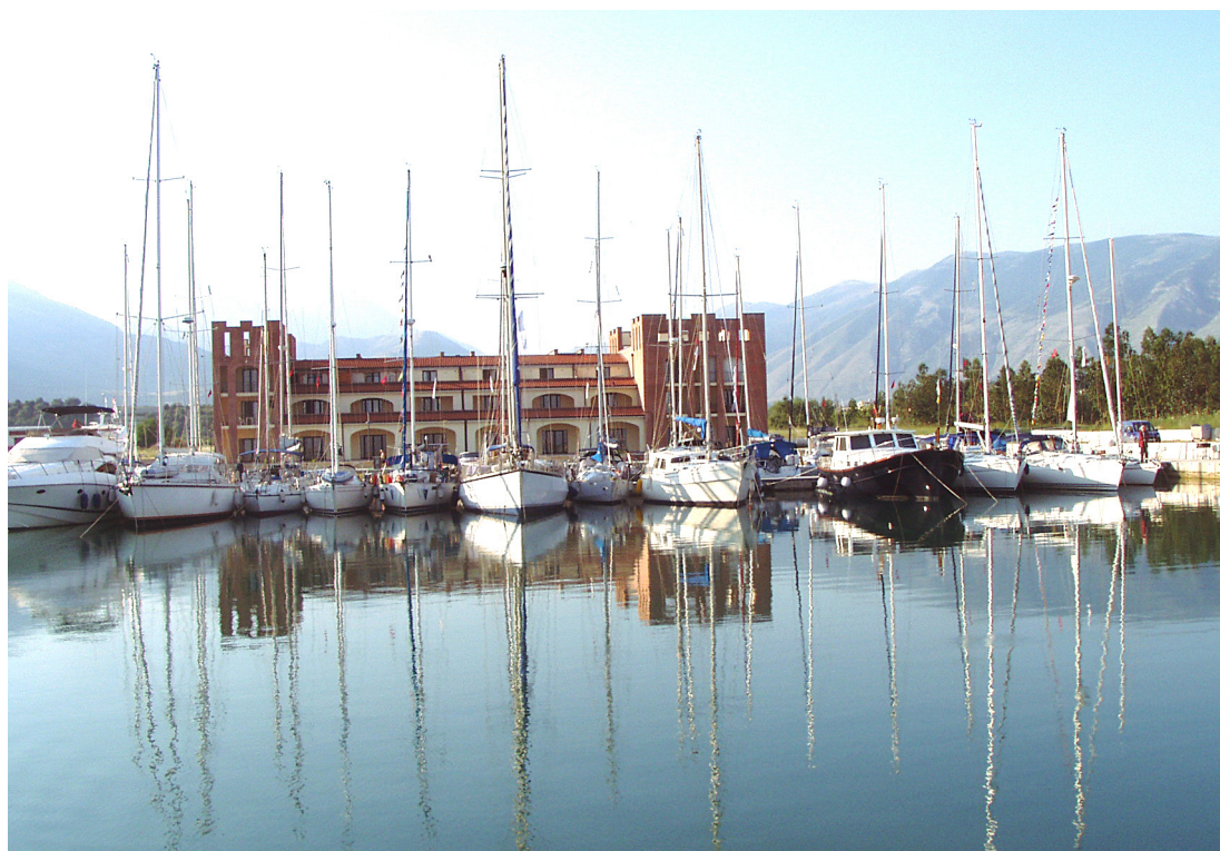
Am Steg vor den Gebäuden der Marina
