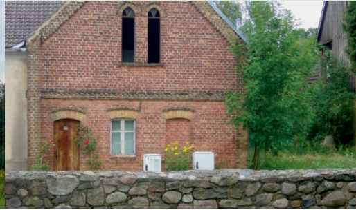
Gebäude in Raben
