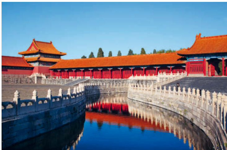
Fünf Brücken führen über den Goldwasserfluss zum Tor der Höchsten Harmonie.
