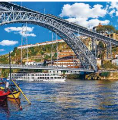
Portos Bogenbrücke Ponte de Dom Luis I.
