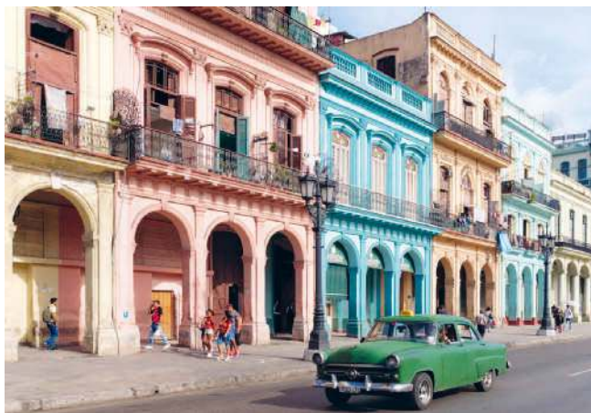
Die Altstadt Häuser am Malecón brauchen wegen der salzhaltigen Seeluft oft neue Farbe
