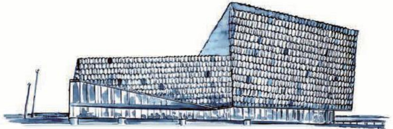
Die Harpa (isländisch für Harfe) ist ein Konzert- und Konferenzhaus, das aus zwei Gebäuden mit schrägen Kanten besteht. Für seine Fassade hat sich der isländische Künstler Ólafur Eliasson eine wabenartige Struktur aus besonderem Glas mit Farbeffekten ausgedacht, die in der Form an die Basaltsäulen an den Küsten erinnert und je nach Wetter und Tageslicht immer andere Farbspiele hervorbringt.
