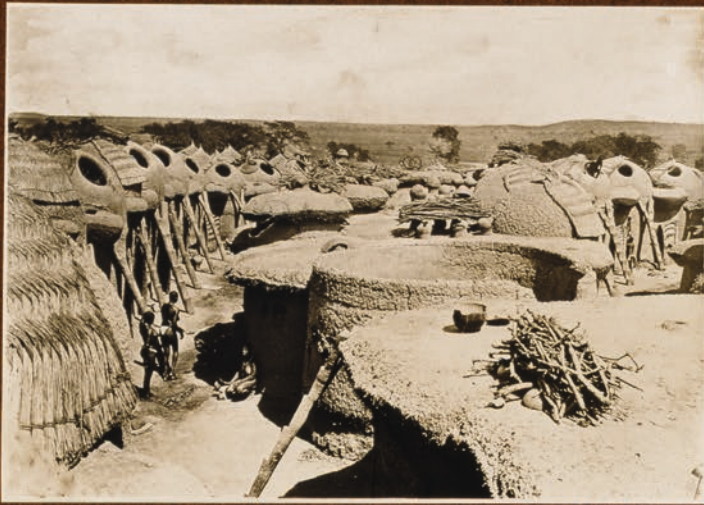
Vue intérieure d'un tala
