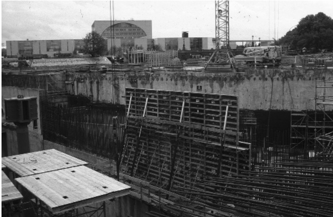
Abb. 1.2 Verankerte Baugrubenwand in Berlin.
