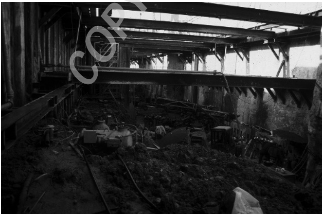
Abb. 1.1 Ausgesteifte Baugrube.
