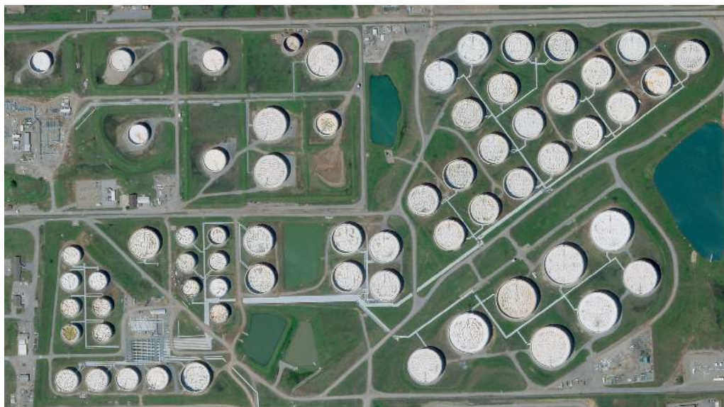
Rohöltanks in Cushing, US-Bundesstaat Oklahoma
