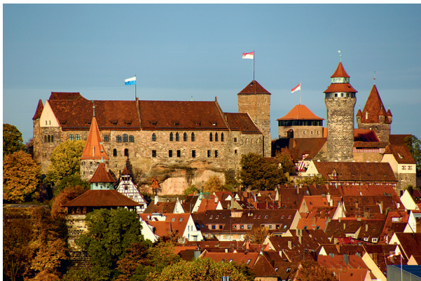
Blick über die Dächer der Stadt auf die Kaiserburg
